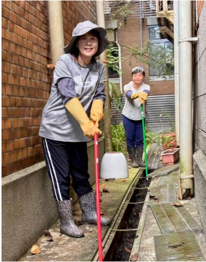
挖除水溝汙泥
